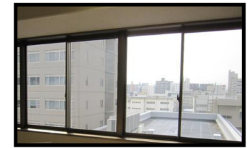
高層階に遮光フィルム取設。
