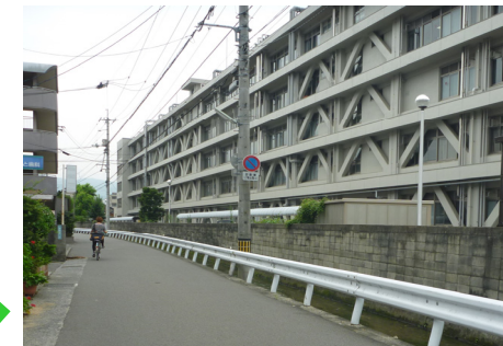
理学部北側ブロック塀
