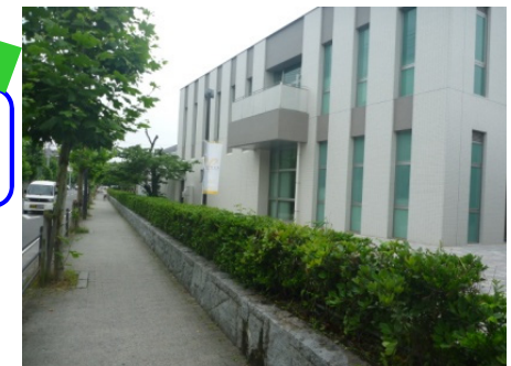
文京3番地区東側石積み囲障
