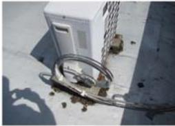
保温材の欠落で電線剥き出し
