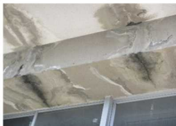
補修後も雨漏れ
