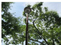
腐食による照度低下
