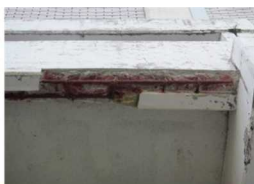
スラブ底の剥落
