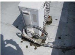
保温材の欠落で電線剥き出し
