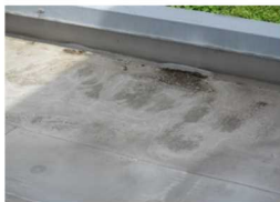
ふくれ、しわ、漏水痕
