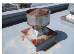
換気設備の腐食
