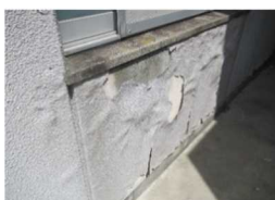
ひび割れ、広範囲の剥がれ
