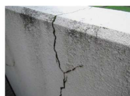
藻が繁殖したひび割れ
