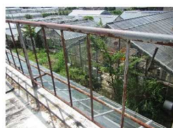
手摺から転落のおそれ
