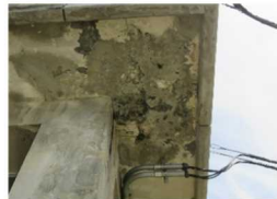
ひび割れ、損壊
