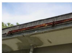
配管落下のおそれ
