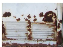
開閉が困難な扉
