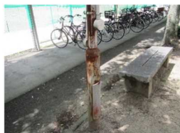
ポール倒壊のおそれ
