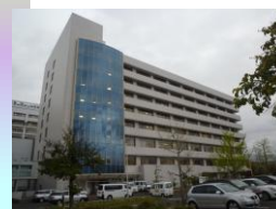
2001年（経年24年） 附属病院2号館
