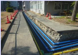
2017年 更新給水管
