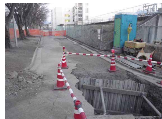
【排水管・柵施工状況】
