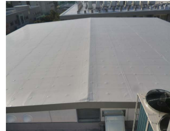
【外観屋上防水】
