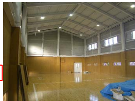
【武道場内部西面】
