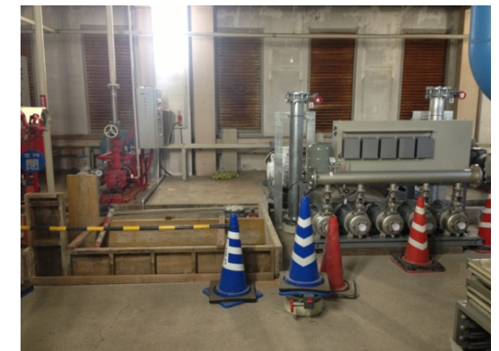
【基礎施工状況】
