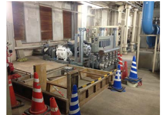
【基礎施工状況】
