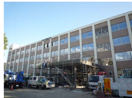
【校舎外観北面】
