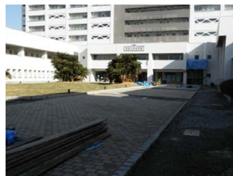
【工事状況(外構)】
