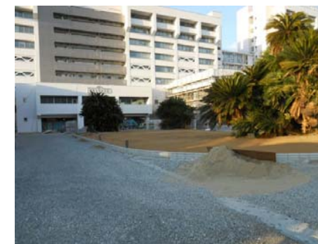
【工事状況(外構)】
