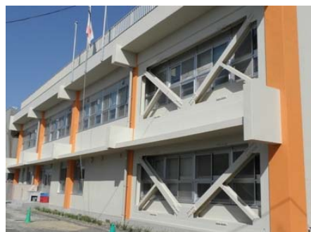
【改修後(南面外観)】
