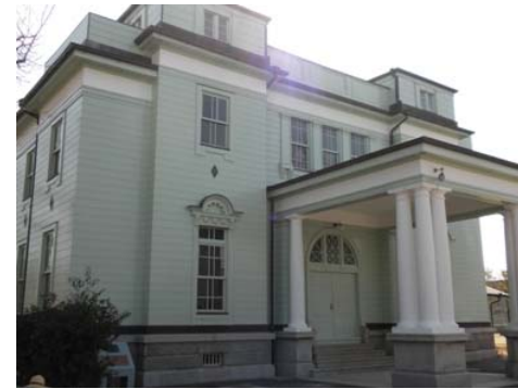
【改修後(西面外観)】
