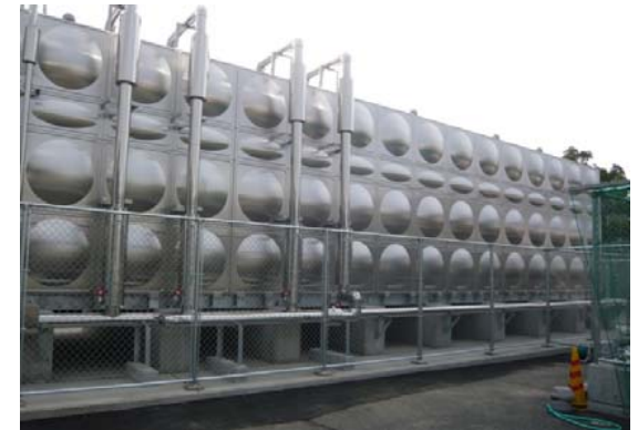
【受水槽設置完了】
