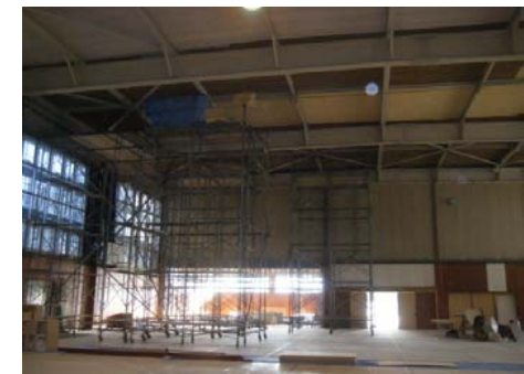
【内装改修状況】
