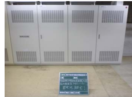
【蓄電池交換完了】
