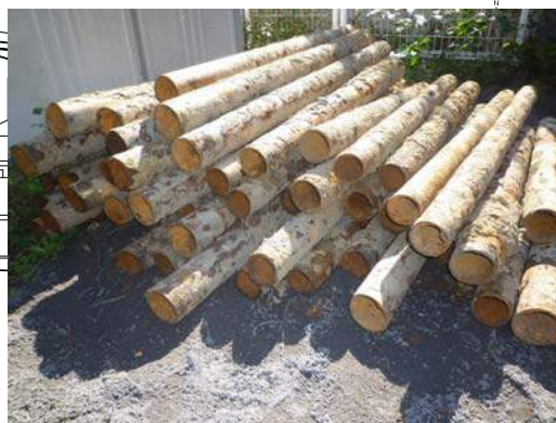
腐食した給水管
