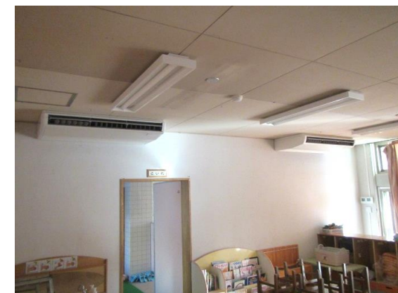
園舎空調新設
