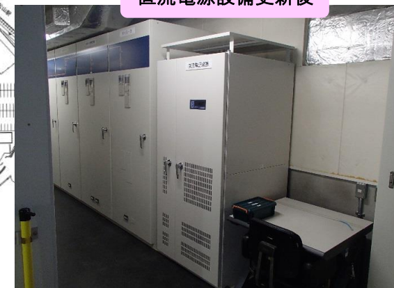
直流電源設備更新後
