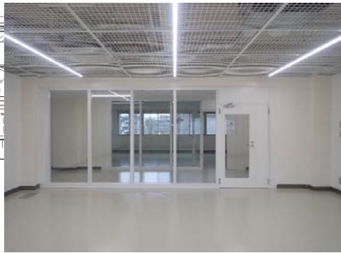
内部改修 完成
