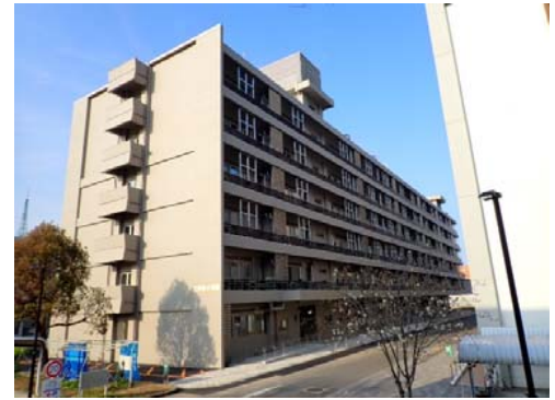
外部改修 完成
