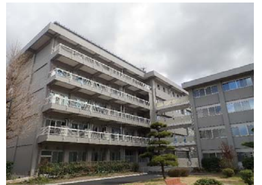
外部改修 完成
