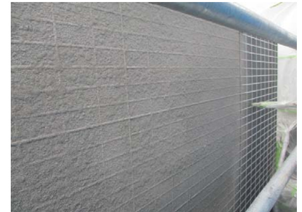
外壁改修① 施工中
