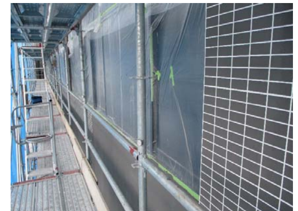
外壁改修② 施工中
