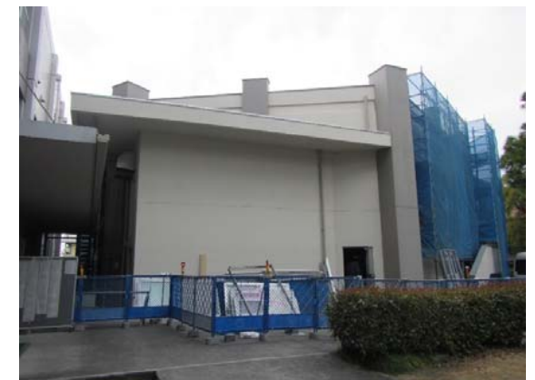
外部仮設状況
