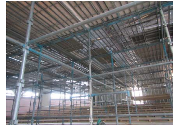
内部改修 施工中
