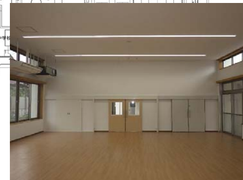
内部改修 完成
