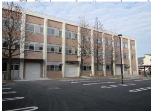
外部改修 完成
