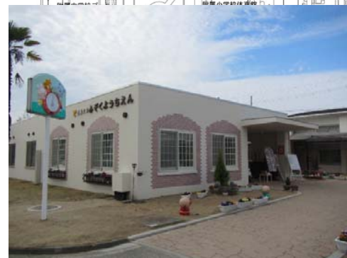
外部改修 完成
