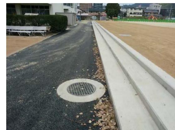
外構整備 完成
