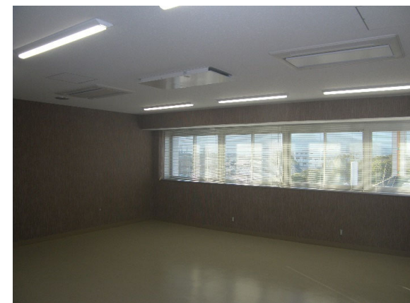
内部改修 完成
