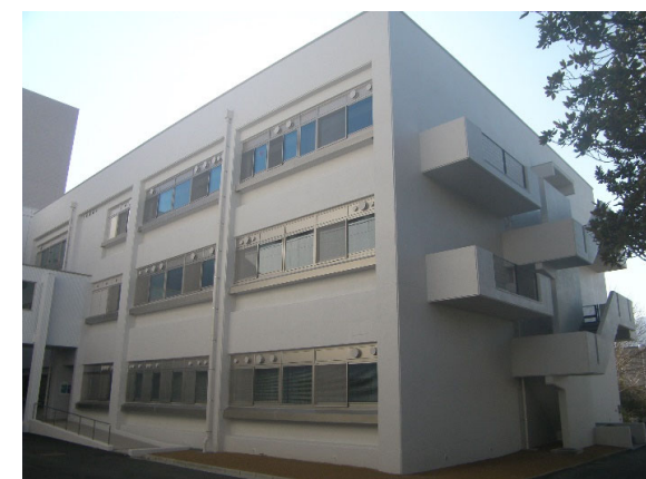
外部改修 完成
