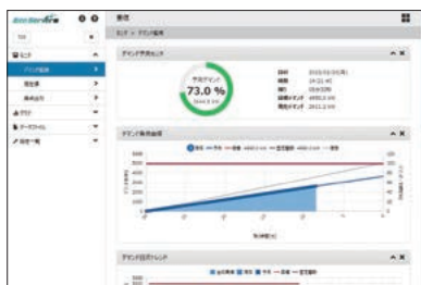
電力監視装置取設
