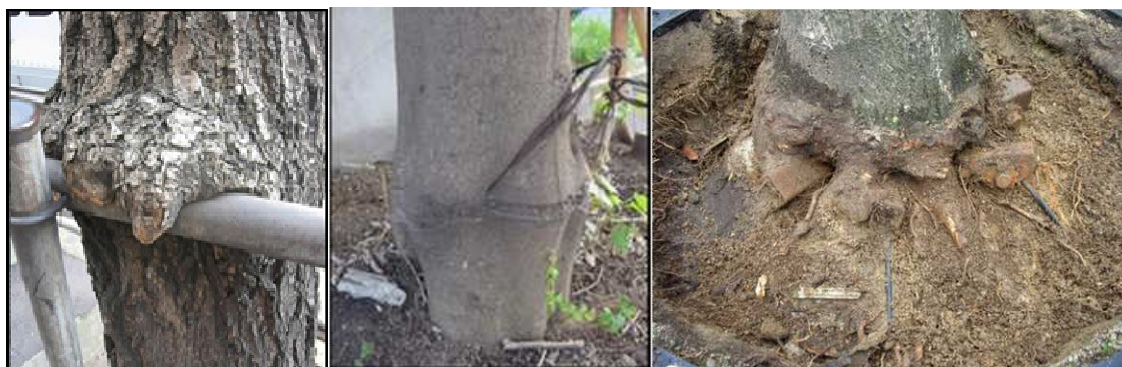
写真 支柱材の食込み 3)
