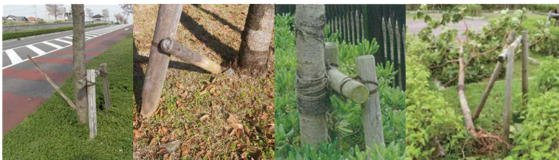
写真 支柱の損傷 3)
