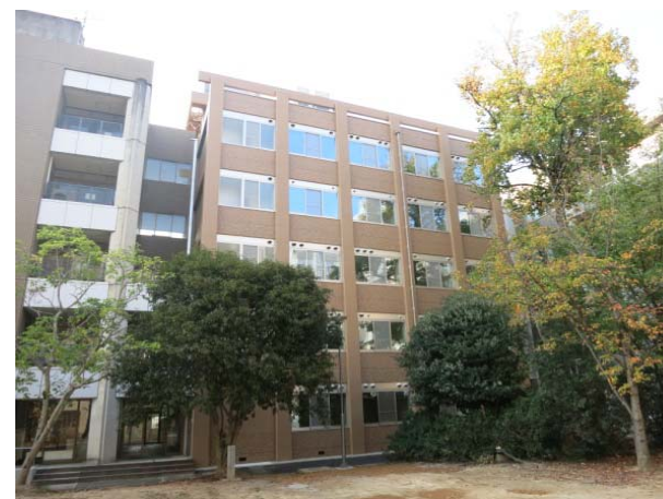
【農学部3号館北面】
