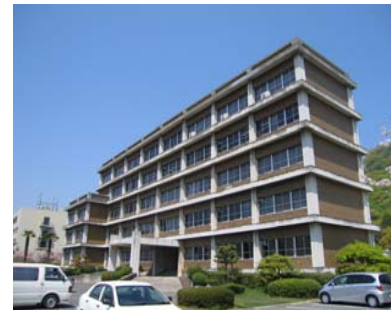
【改修前(南東面外観)】
