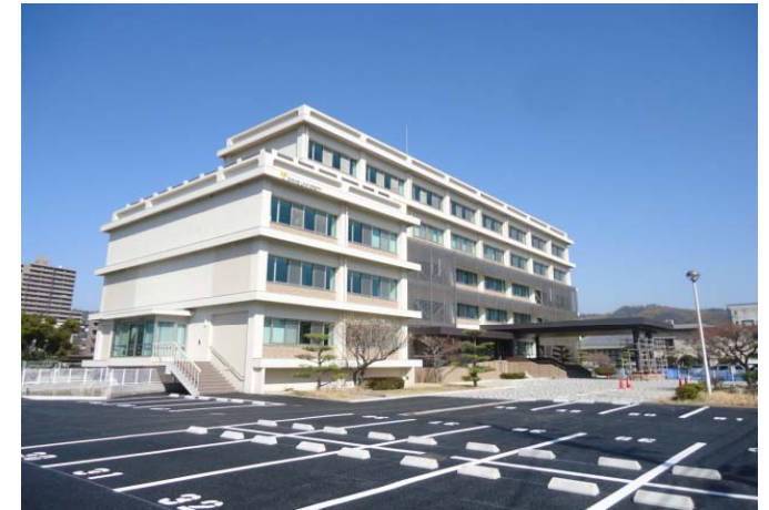
【改修後(南西面外観)】
