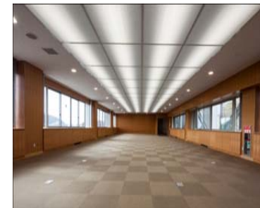
【改修後(第1会議室)】
