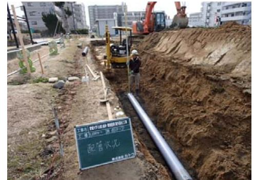
【排水管施工状況】
