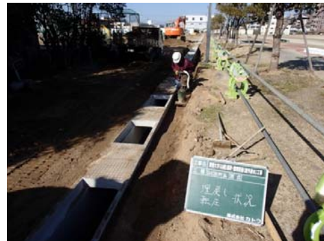
【側溝施工状況】
