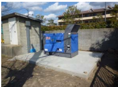
【発電機据付状況】
