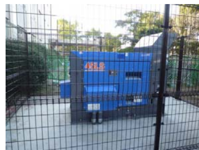
【発電機据付状況】
