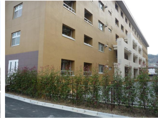
【既設棟耐震補強】
