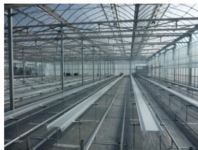
【植物工場内部】
