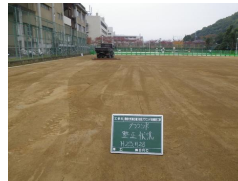
【復旧完了①】
