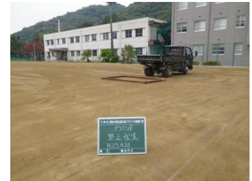
【復旧完了②】
