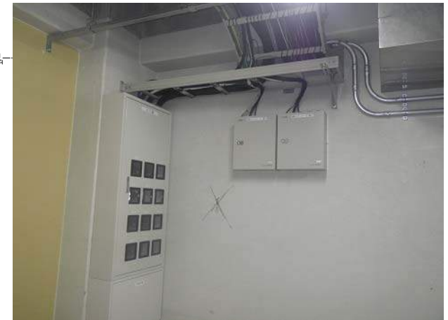
電力量計 設置
