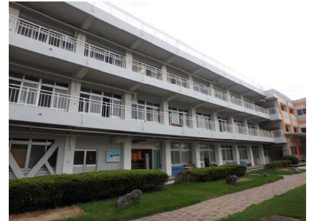
建具・塗装改修
