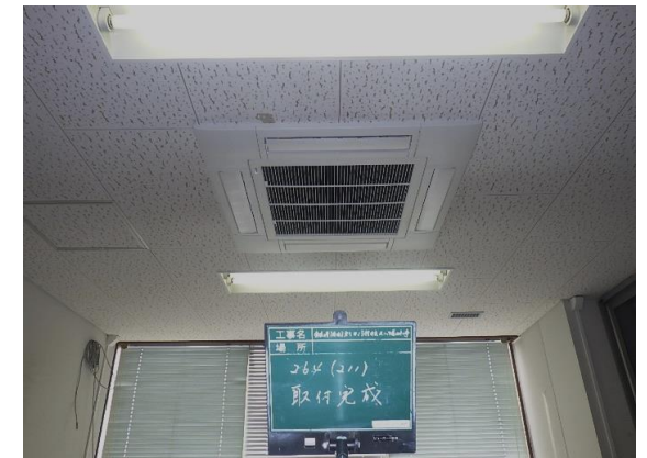
室内機改修後
