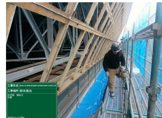
外壁材撤去後
