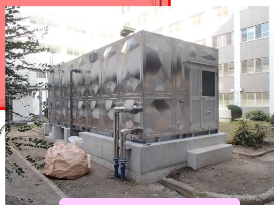
受水槽新設状況
