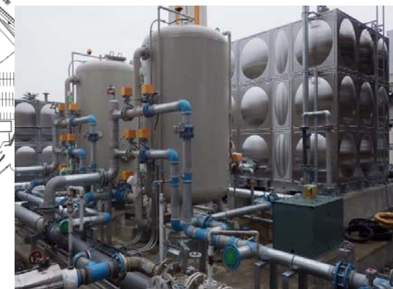
濾過装置改修後
