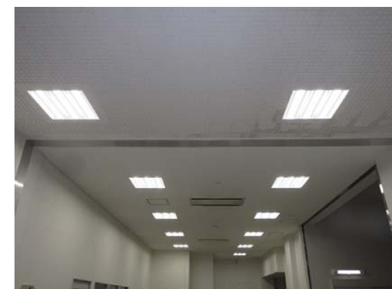
照明設備更新②完成
