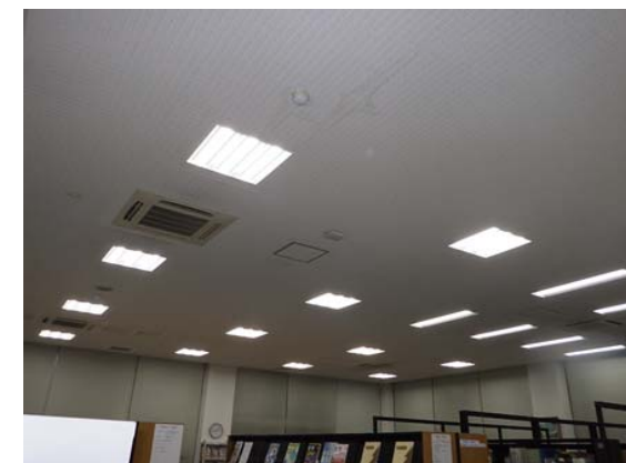
照明設備更新①完成
