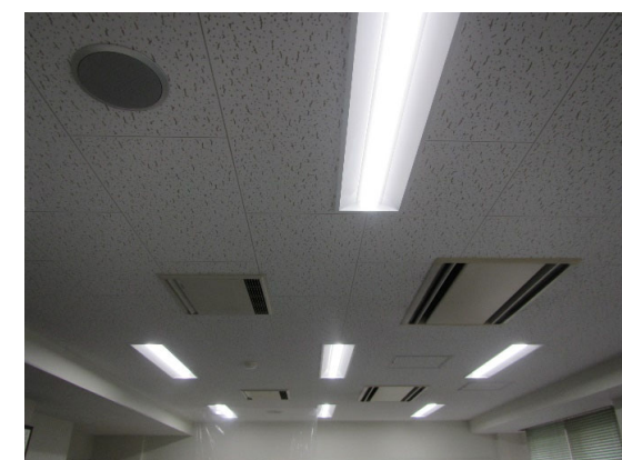
LED照明更新 完成
