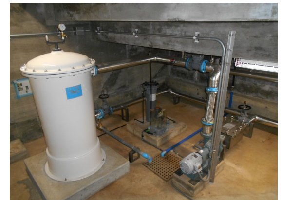
ろ過装置 完成
