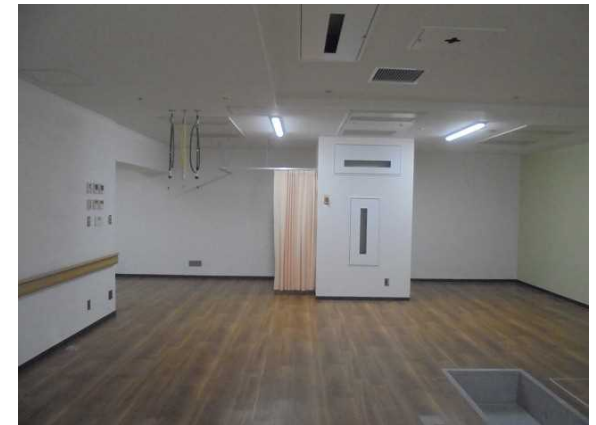
内部改修 完成
