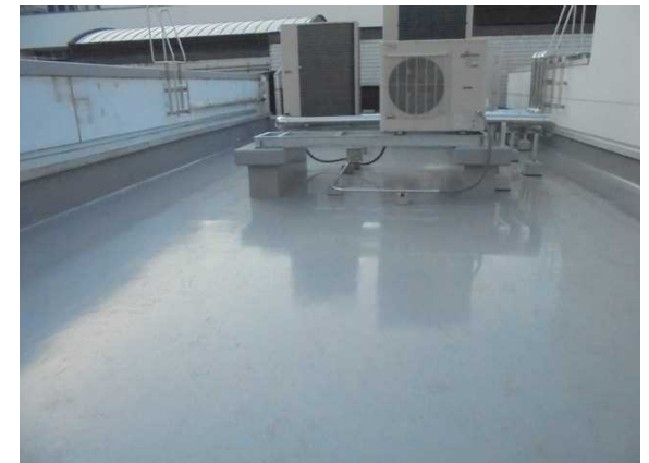
外部改修 完成
