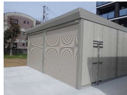
倉庫新営 完成
