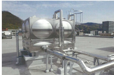
高置水槽 完成
