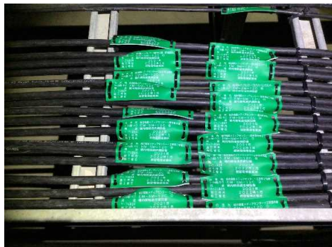
ケーブル配線 完成
