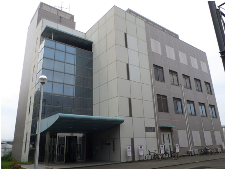
既存建物外観
