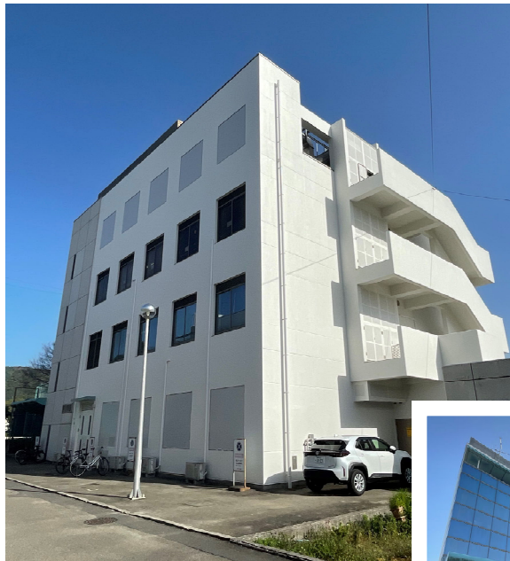
建物外観 (北西側)
