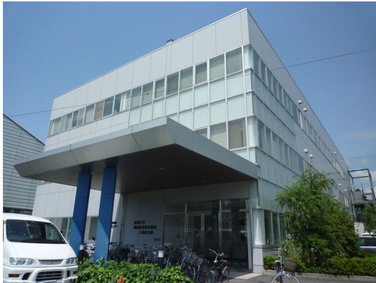
既存建物外観
