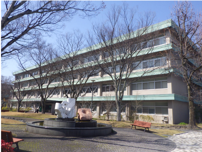
既存建物外観
